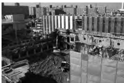
工事中の板橋キャンパス 2003（平成15）年
