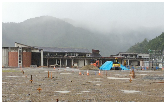
震災遺構の整備が進む旧石巻市立大川小学校
