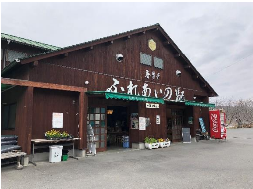
普賢寺ふれあいの駅の外観
