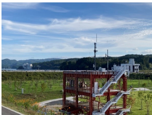
震災後に盛り土された高台から臨む防災対策庁舎
