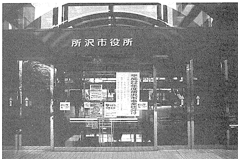
▲所沢市庁舎外観
